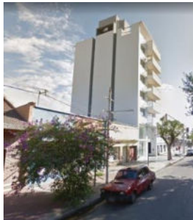
Edificio en Trenque Lauquen
